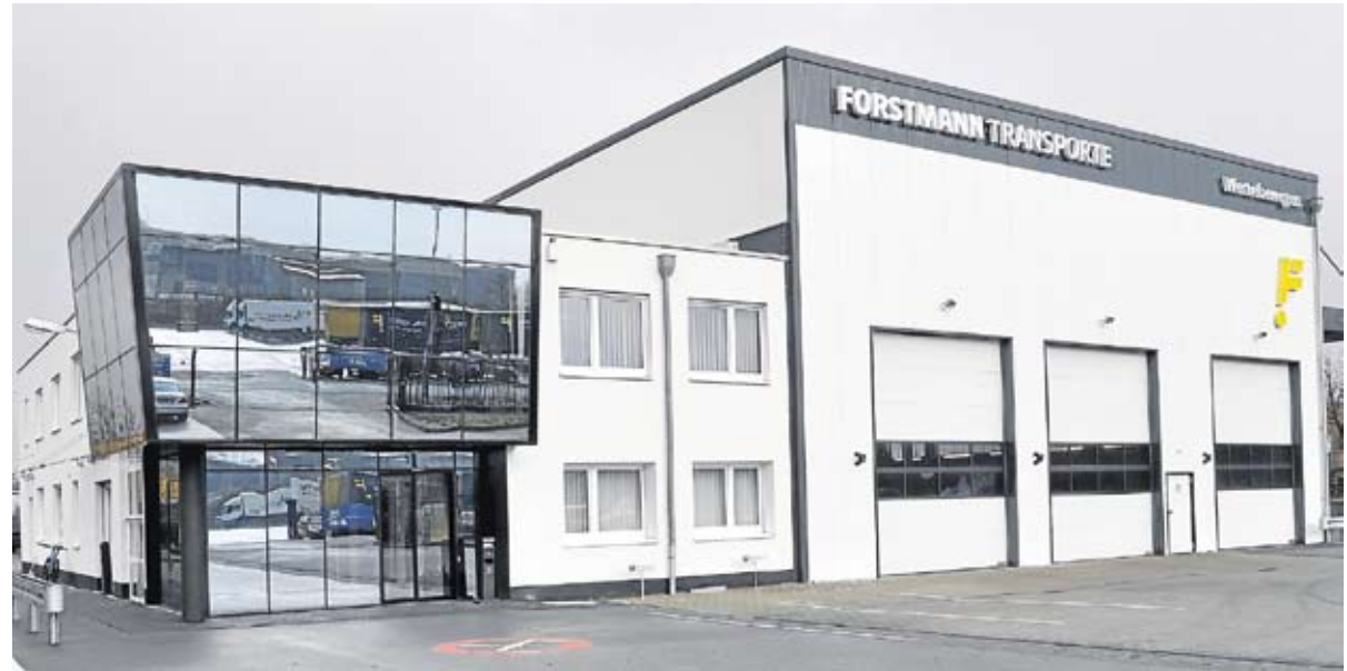
Mehr Platz für das Team am Firmensitz im Industriegebiet Uffeln: Das erweiterte Bürogebäude sowie die neue Halle für Werkstatt und Lager.
